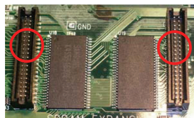
<図4：MPC5000ソケット凹み部分>
